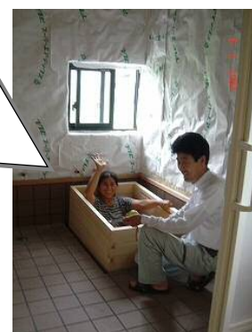
ひのき風呂の仮設置
