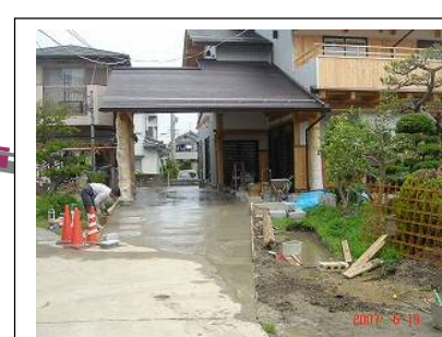
玄関前までをコンクリ舗装
