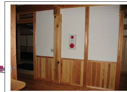
防災用の警報装置を設置
