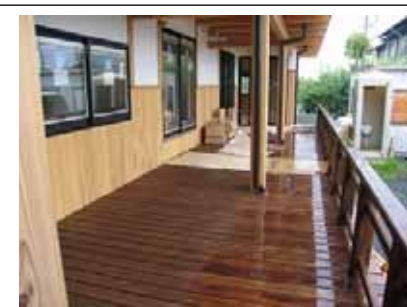
テラスとベランダを塗装したよ
