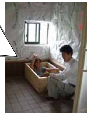
ひのき風呂の仮設置
