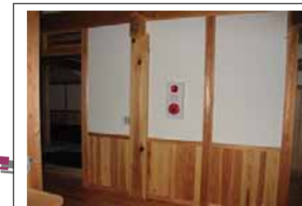
防災用の警報装置を設置
