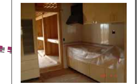
2階のシステムキッチン設置
