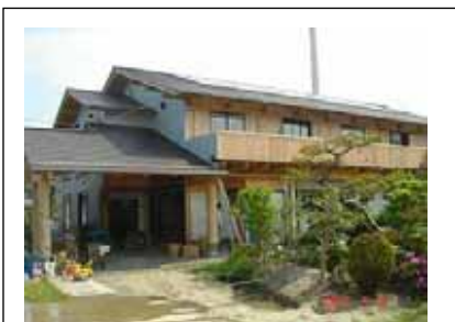
5月中旬全ての足場を撤去
