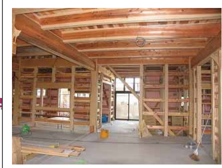
H19年3月6日 床暖配管後、コンクリで床を全面覆った
