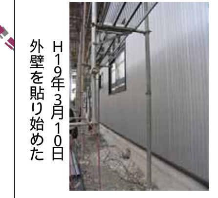
H19年3月10日 外壁を貼り始めた
