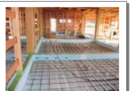
H19年2月21日 床暖の配管完了
